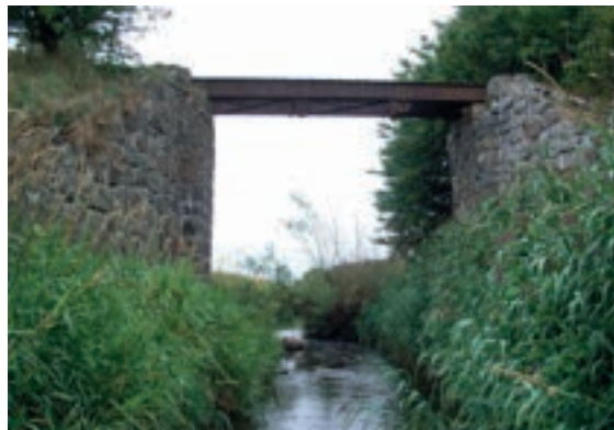
Fundamenterne ved den gamle jernbanebro findes stadig. Brodækket er fjernet men kan genetableres.
